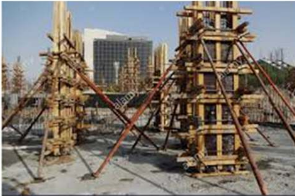
Fig.1.26. column formwork
